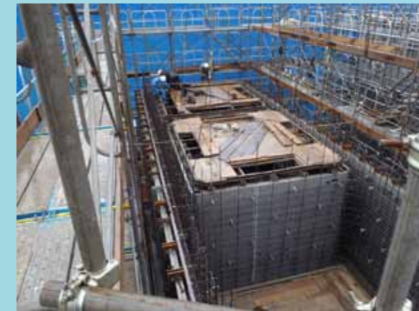
内型枠スライド
